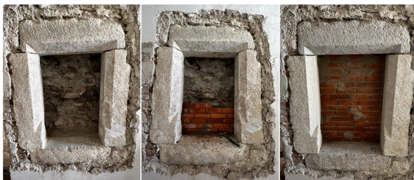
Fig. 7 – Zidăria de cărămidă nou adăugată
