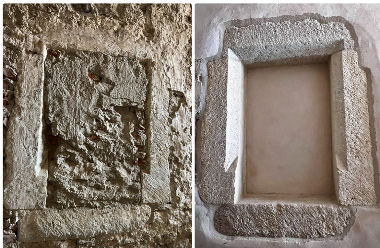
Fig. 8 – Completări cu mortar fin în spațiile lacunare, inclusiv în cadrul din jurul ancadramentului
