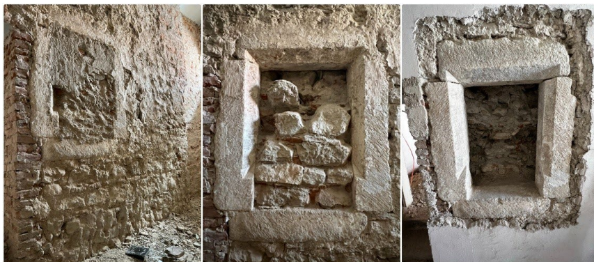
Fig. 5 – Etape ale eliminării umpluturii
