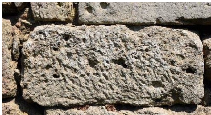
Fig. 11. Molon din zidul de sud al castrului prelucrat cu târâcopul.
