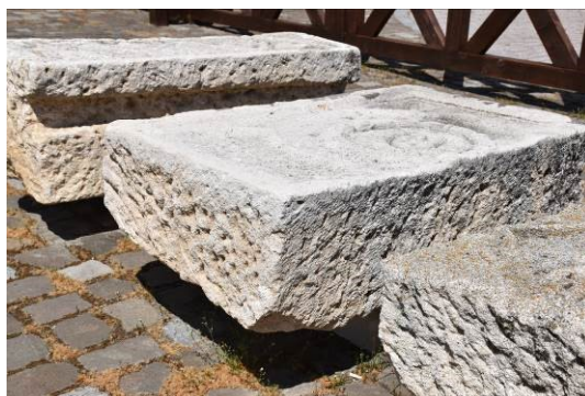
Fig. 12. Reliefuri votive- laterale debitate cu târâcopul.
