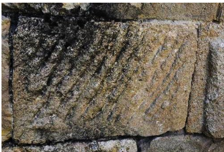
Fig. 20. Bloc din zidul castrului tăiat cu spițul.
