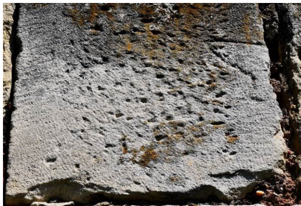
Fig. 26. Molon de parament finisat cu gradina (Castru).
