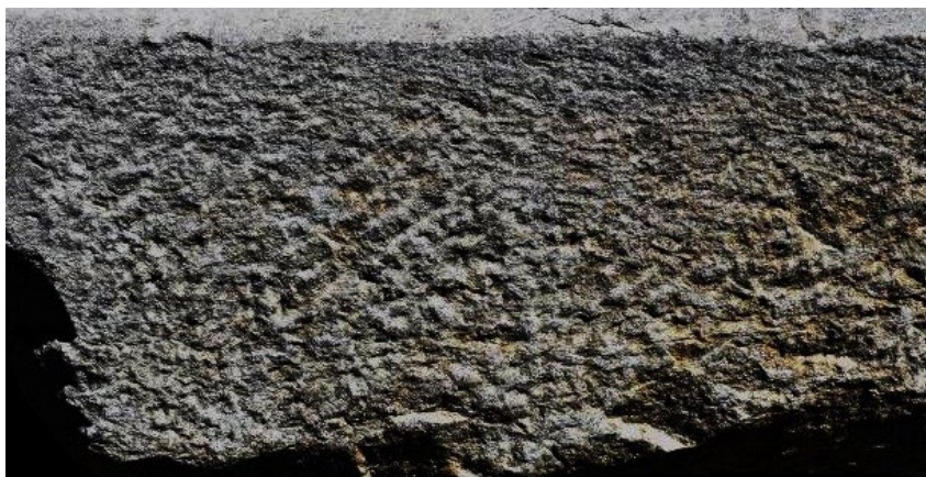
Fig. 21. Baza inferioară a unei inscripții prelucrată cu spițul.
