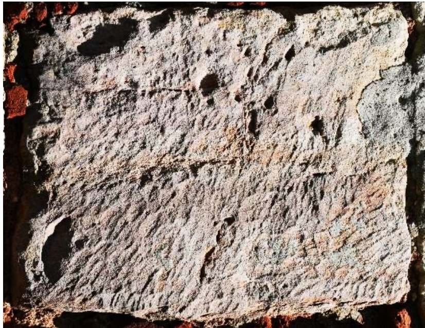
Fig. 17. Bloc din zidul castrului debitat cu securea.
