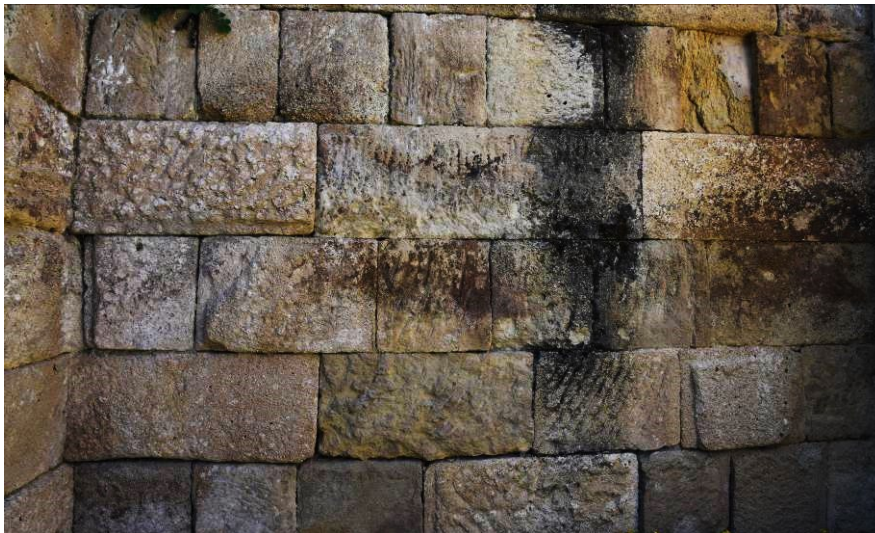
Fig. 22. Paramentul turnului cu moloanele corectate pe lungime in situ .
