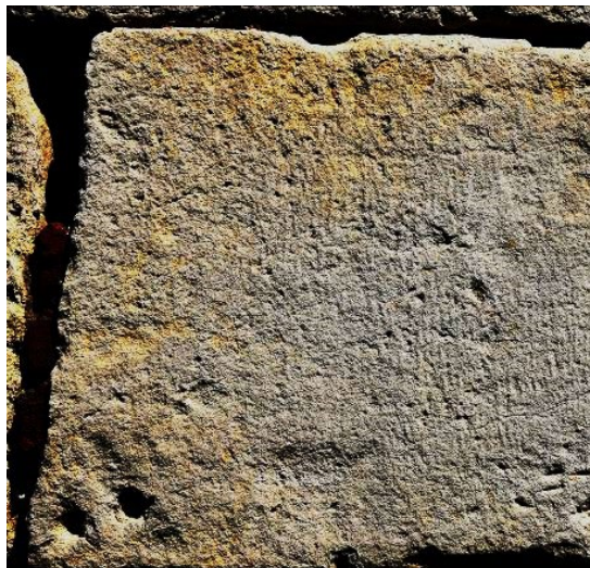
Fig. 31. Molon îndreptat cu dalta (Castru).
