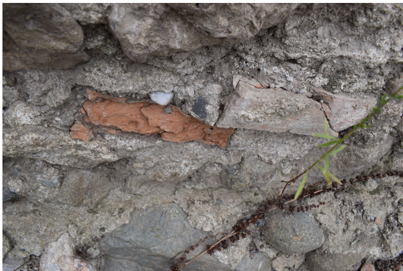
Fig. 9. Exfolieri ale materialului ceramic din zidărie.
