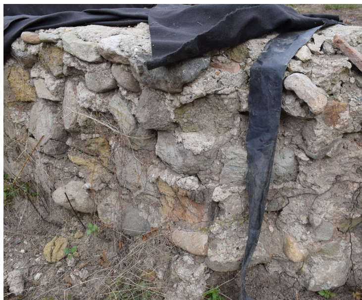
Fig. 8. Exfolieri petrografice ale materialului din zidărie.
