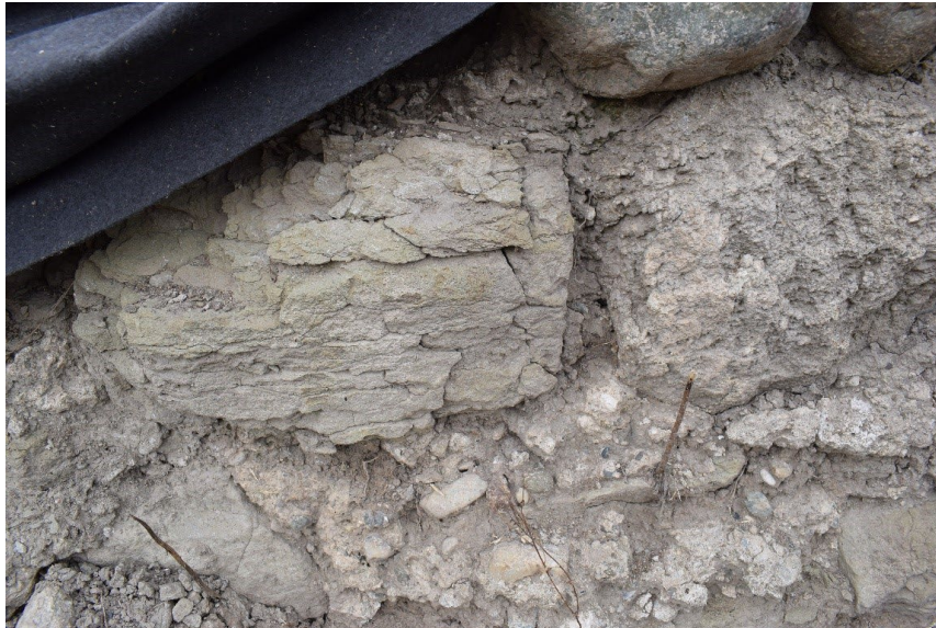
Fig. 7. Solziri și exfolieri ale materialului litic.
