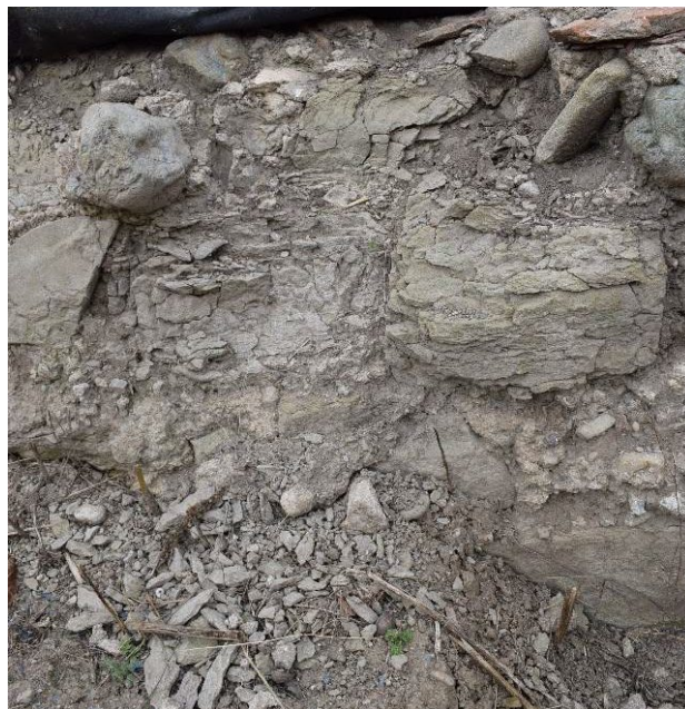
Fig. 6. Solziri și exfolieri ale materialului litic.
