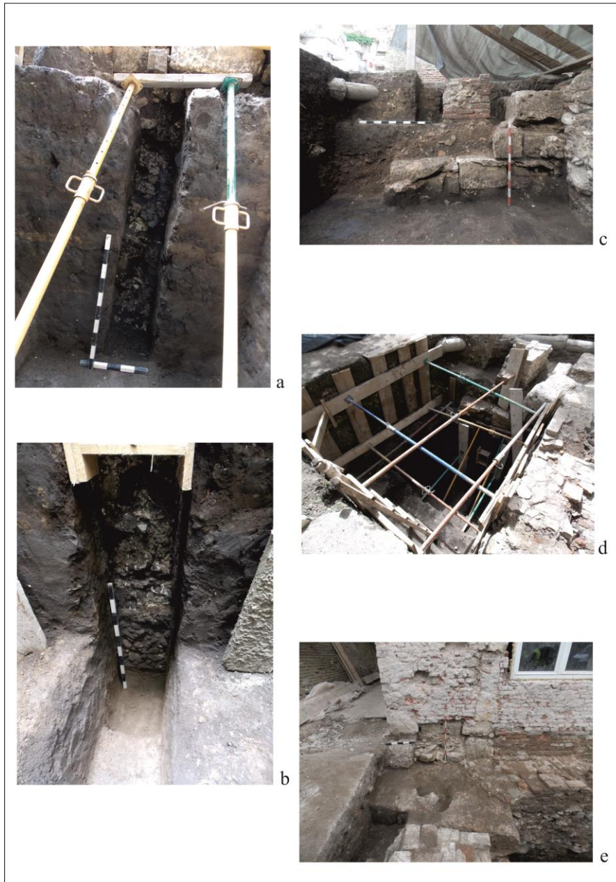
Fig. 13. Imagini foto Caseta 11; a-b) fundația Z. 4D, Parament de Est; c) Z. 4A, Parament de Est; d) imagine generală cu sistemul de asigurare a pereților; e) secțiune transversală pe Z. 4A surprinsă în Paramentul de Sud al Z. 6.
