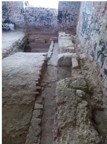
Fig. 17. Caseta 13, traiectul Z. 4A identificat în interiorul clădirii.
