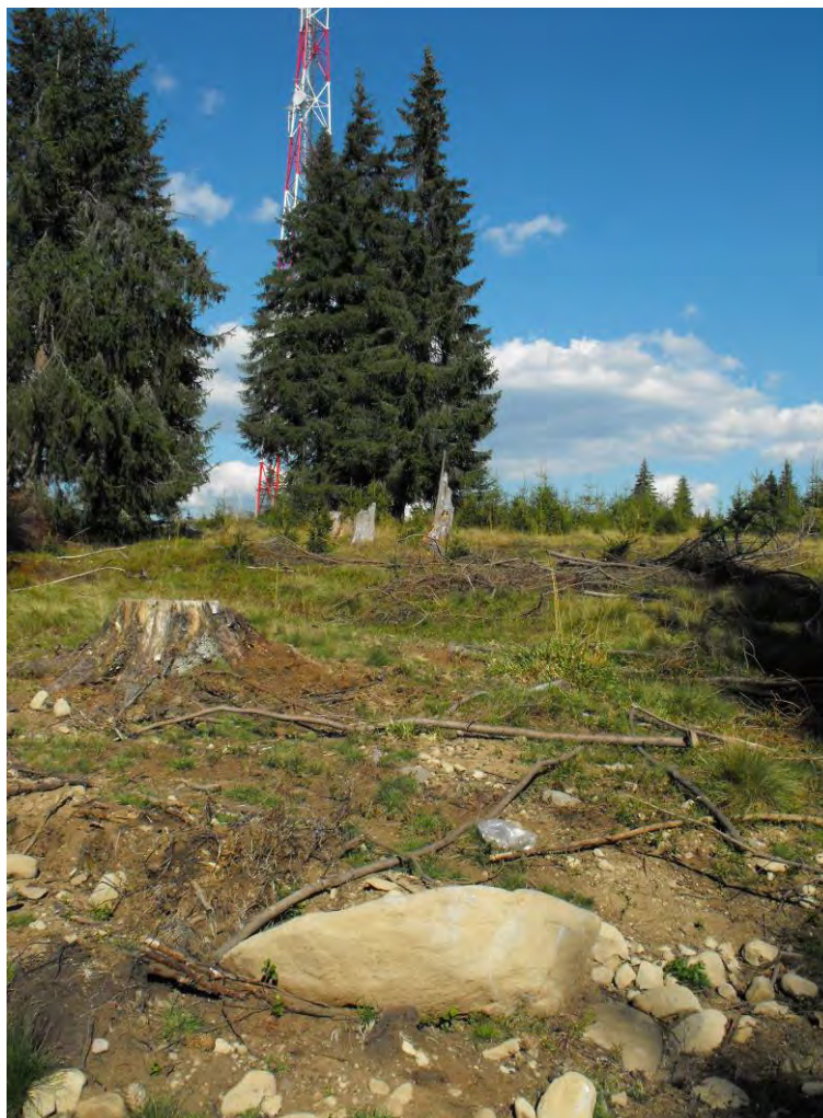
Fig. 41. Piatra 22 de pe traseul cablului electric.
