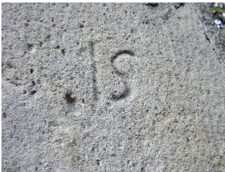
Fig. 15. Gresie cu ciment carbonatic din cariera Șard (Baia), zidul fortificației bastionare, bloc cu însemn de pietrar.
