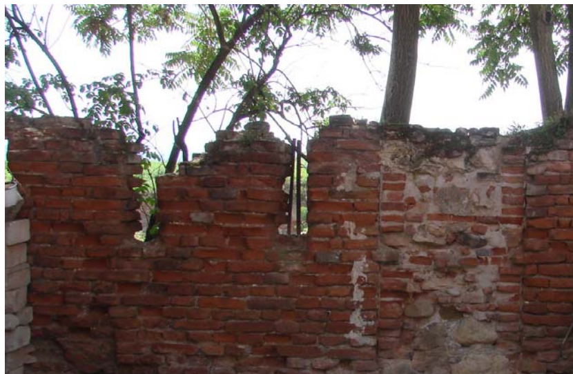
Fig. 6. Latura de sud a cetății medievale din Alba Iulia, segmentul supraînălțat cu zid de cărămidă înzestrat cu crenele, situat între edificiile curții de sus și de mijloc a palatului princiar.
