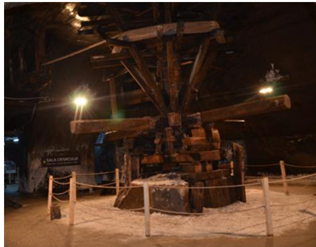
Fig. 5 - Trolitul cu ax vertical (crivacul) din salina Turda
