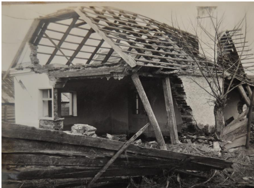
Foto 25. - Casă distrusă de inundații
