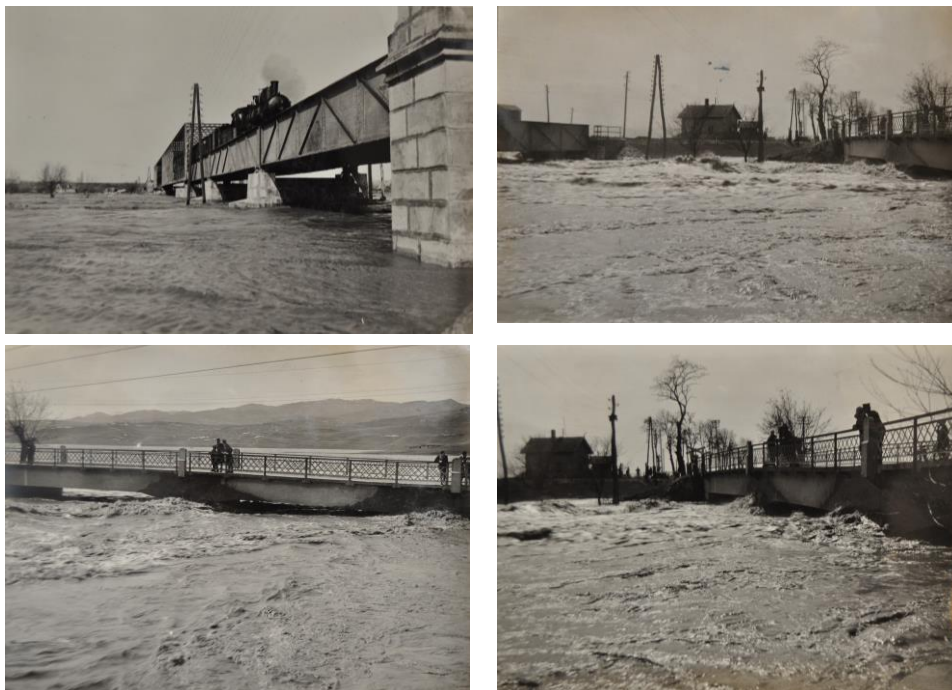
Foto 10-13. În zona podurilor
