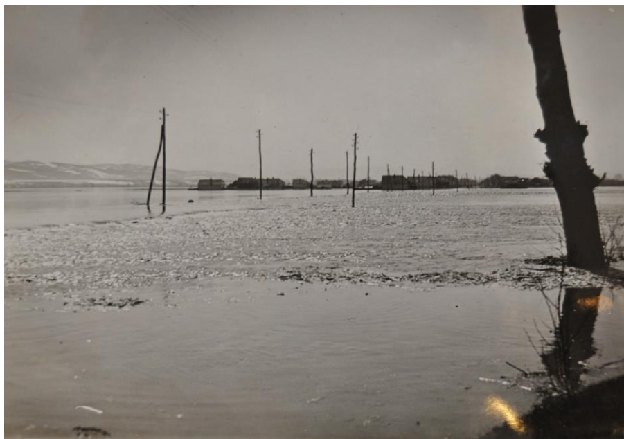
Foto 22. - Terasamentul de cale ferată
