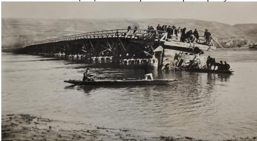
Foto 5. - Podul de la Drâmbar, rupt de apele Mureșului
