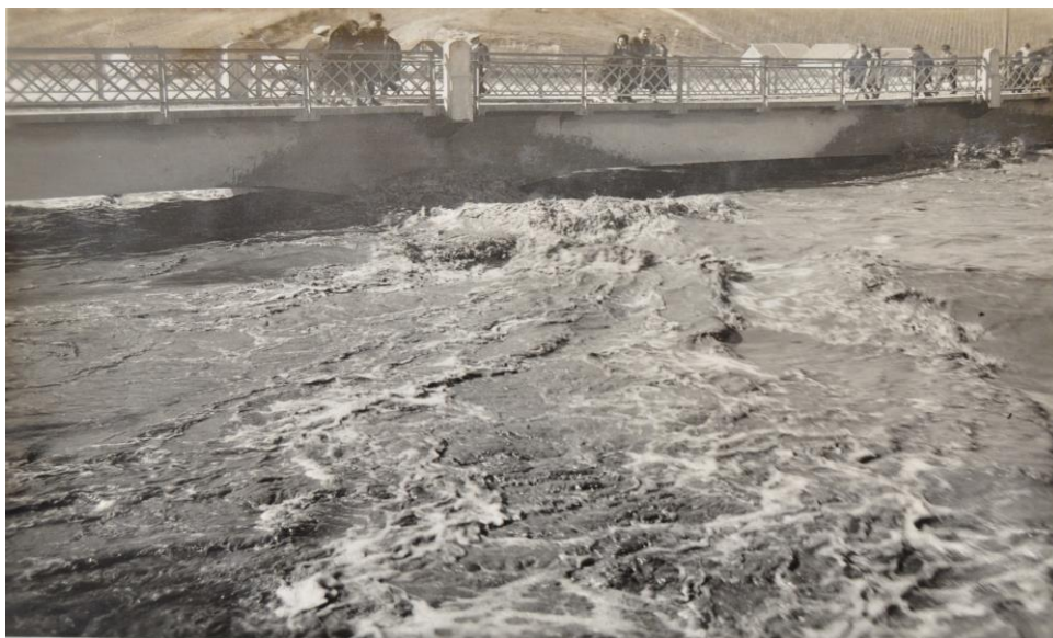
Foto 14. - Nivelul ridicat al Mureșului
