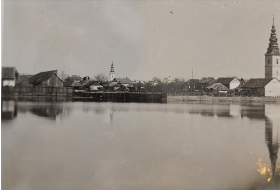
Foto 17. - Vedere din Cartierul Maieri în timpul inundațiilor
