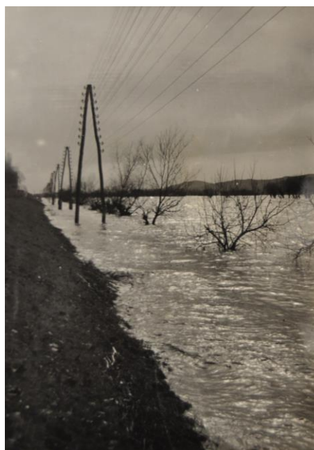
Foto 21. - Terasamentul de cale ferată
