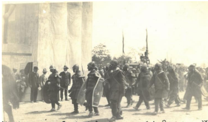
Fig. 46 - Segment din oastea domnitorilor. Colecția MNUAI, CF 778
