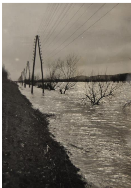
Foto 21. - Terasamentul de cale ferată
