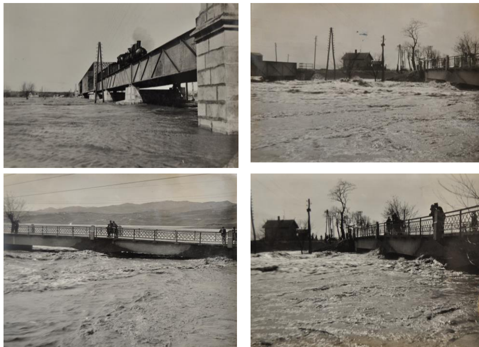
Foto 10-13. În zona podurilor
