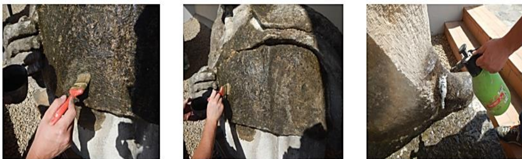
Fig. 2 - Aplicarea tratamentului împotriva atacului biologic
